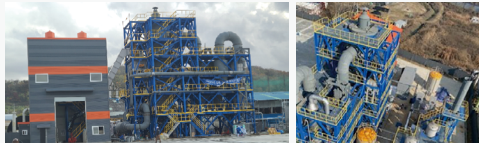
〈50 ton/day급 바이오매스 가스화 시스템 전경〉
